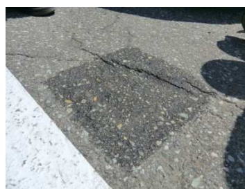
プライマー塗布箇所外観
